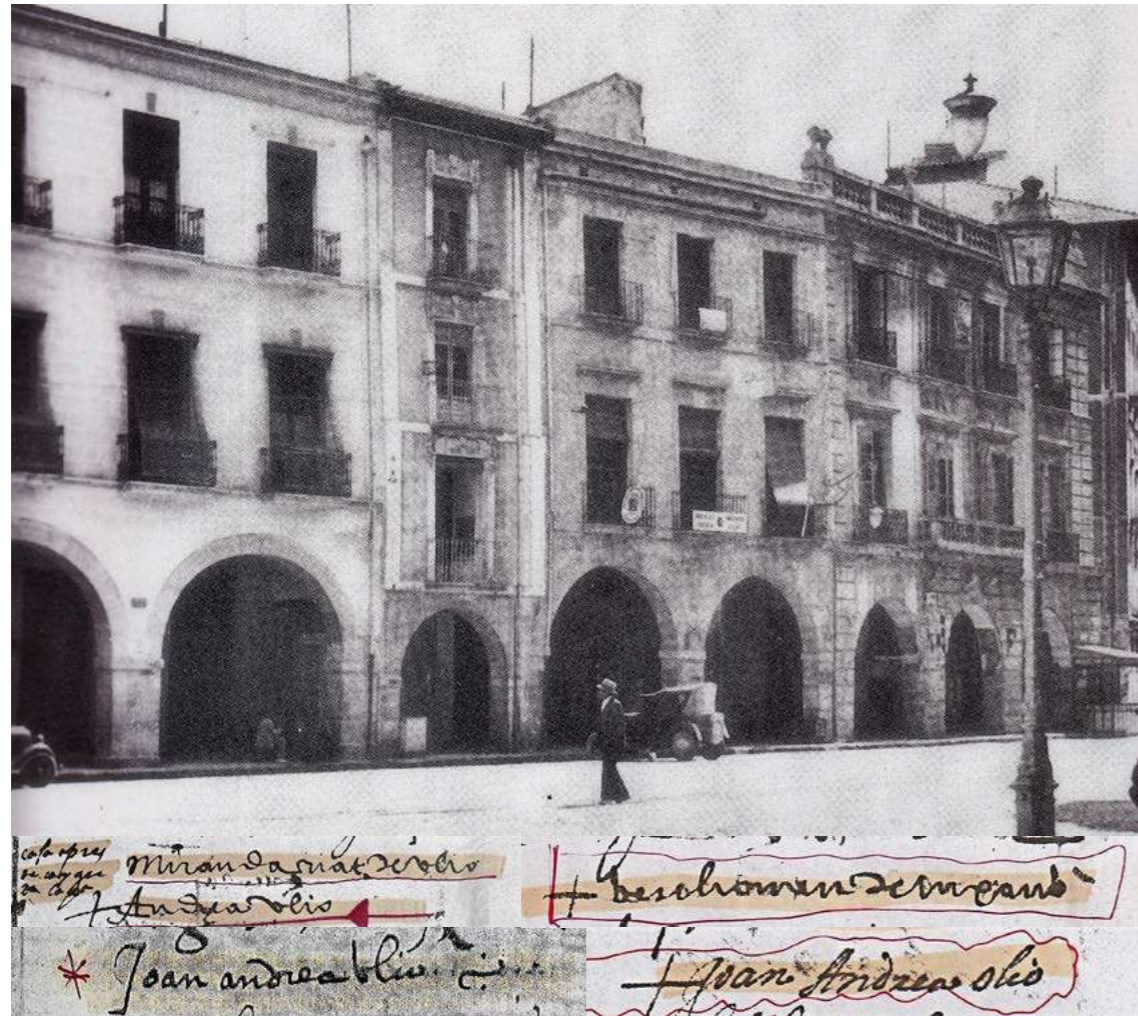
Imagen de la Plaza del Mar (hoy Ayuntamiento) antes de su derribo y remodelación en 1953, donde se ven las arcadas de los porches donde los mercaderes desarrollaban su actividad desde el siglo XVI. En esta plaza vivía Joan Andrea Ulio, cuyo nombre aparece reproducido de los censos del morabati (1572-1590-1602). También copiamos el nombre de Bartomeu de Lugano, que vivía en la Calle Mayor (1572).
